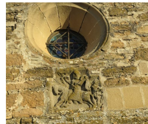
Detalle de la torre de la iglesia
