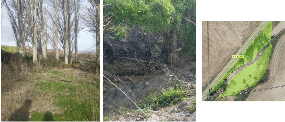
Aspecto actual de la zona comunal con el detalle en la imagen central del vertido de restos bituminosos
