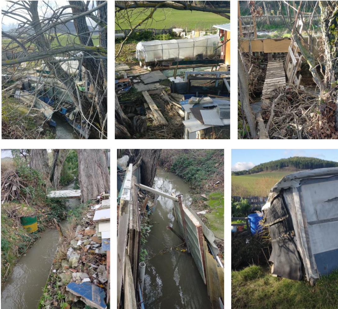
Imagen 25. Aspecto del barranco Termus en algunas de las parcelas de huertas donde se observa la invasión de las riberas y el cauce menor con todo tipo de materiales y residuos, entre ellos muchos elementos flotantes de varios tamaños susceptibles de ser arrastrado en los momentos de crecida y suponer un punto de colapso para el discurrir del agua.
