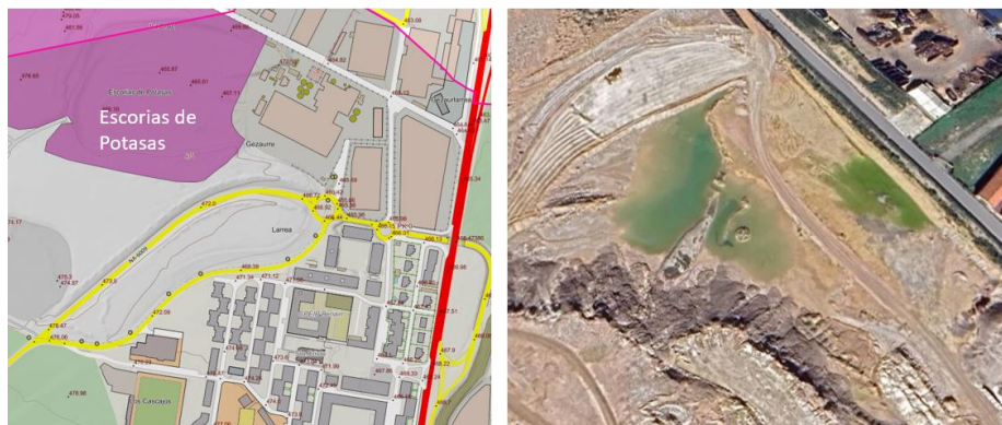
Imagen 18. Zona de Beriain afectada por el vertedero de escoras de Potasas en el Polígono Industrial Meseta de Salinas-Gezaurre.
