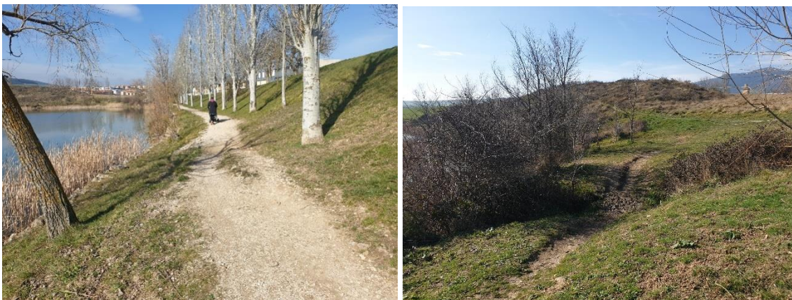
Imagen 48. A la izquierda imagen del camino mal conservado. A la derecha fin del camino acondicionado en dirección de la margen Oeste.
