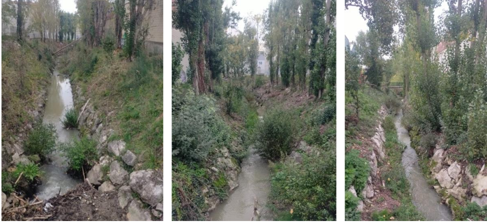
Imagen 32. Detalle del primer tramo entre naves industriales de la regata Zaldualde.
