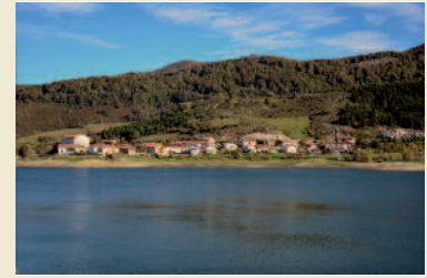
EMBALSE de Eugi, una de las principales fuentes de abastecimiento de Pamplona.
