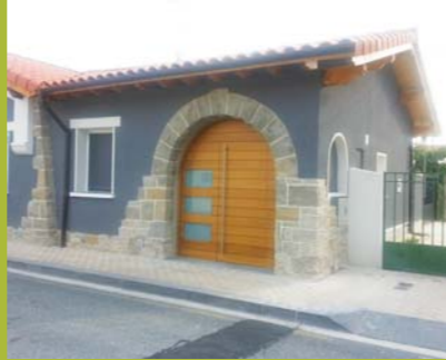
Rehabilitación casa en la Txantrea
