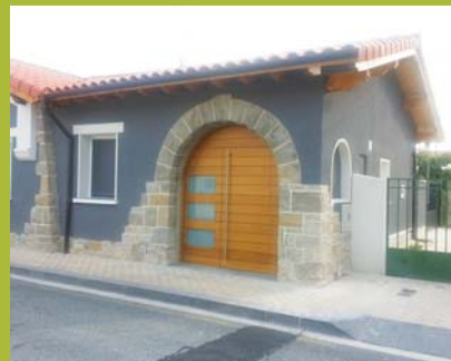
Rehabilitación casa en la Txantrea
