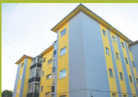
Rehabilitación de fachada y cubierta en Beriáin
